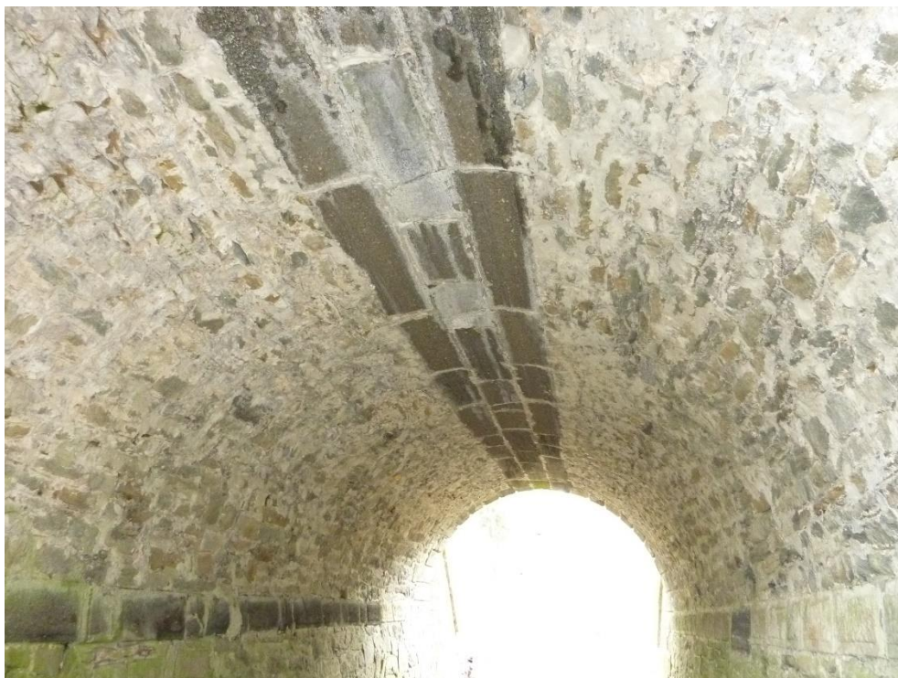
Foto 4: Průsaky vody v klenbě, místy popraskané a vypadané spárování
