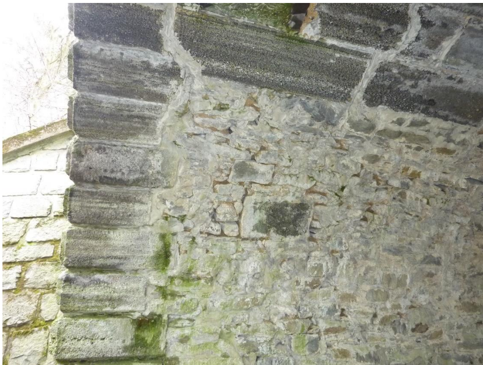
Foto 3: Místy vypadané spárování, degradace kamene
