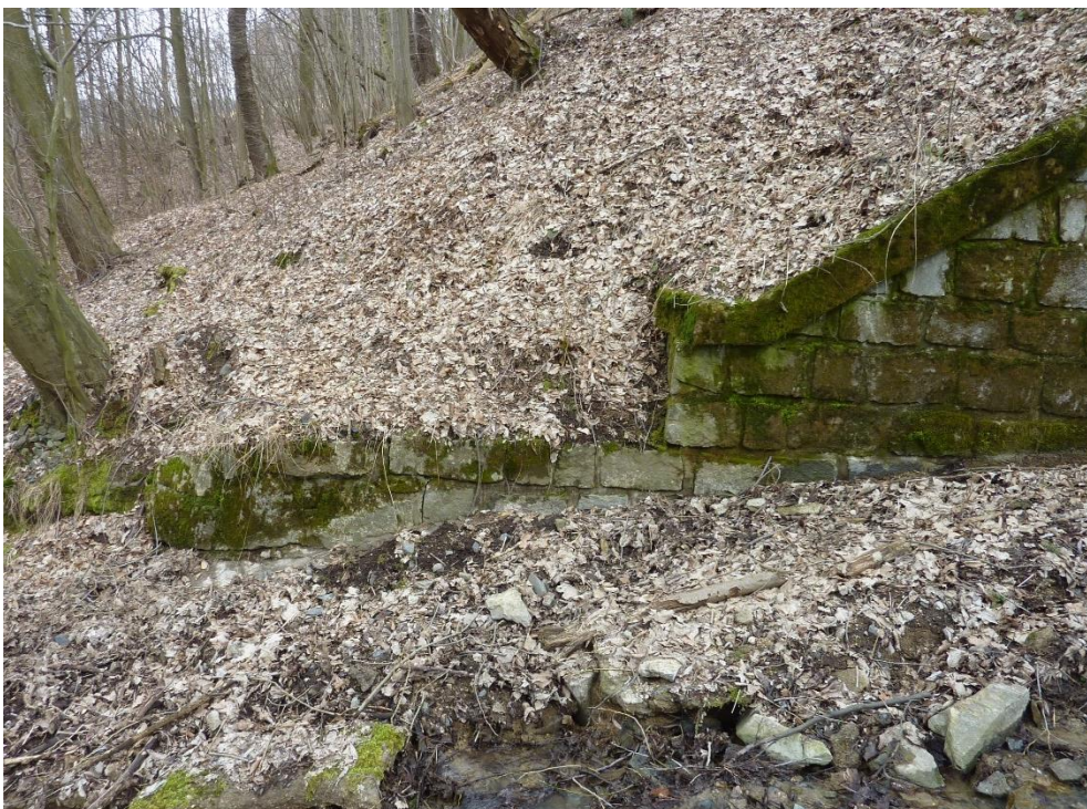
Foto 6: Uvolněné kameny v koncích křídel
